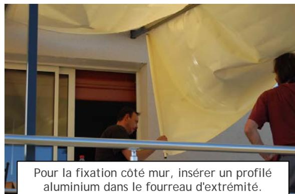
Pour la fixation côté mur, insérer un profilé aluminium dans le fourreau d'extrémité.
