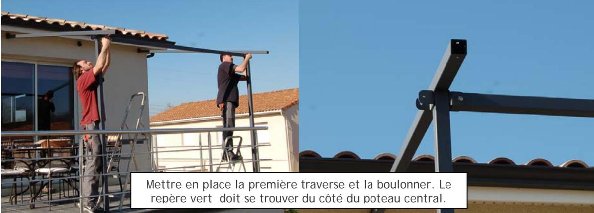
Mettre en place la première traverse et la boulonner. Le repère vert doit se trouver du côté du poteau central.
