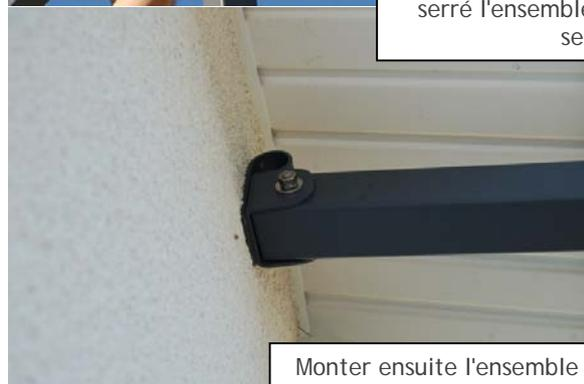
Monter ensuite l'ensemble chevron/poteau suivant, s'il s'agit d'un poteau central, il faudra boulonner un support de traverse de chaque côté.
