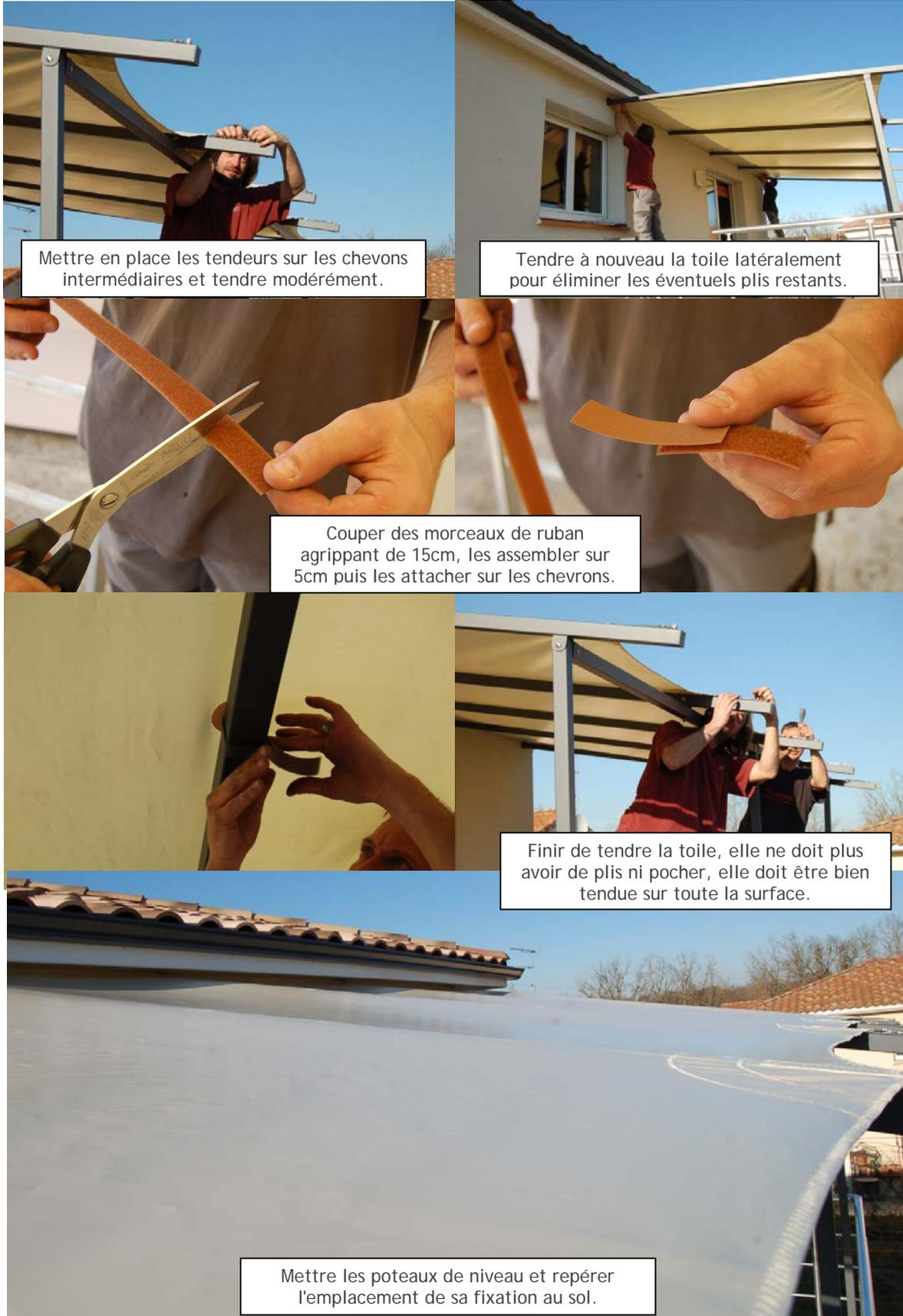
Mettre en place les tendeurs sur les chevrons intermédiaires et tendre modérément.
