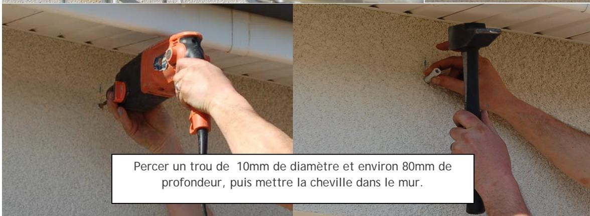
Percer un trou de 10mm de diamètre et environ 80mm de profondeur, puis mettre la cheville dans le mur.
