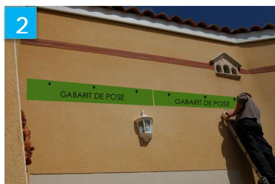
**1** Positionner le gabarit de perçage sur le mur à l'aide de ruban adhésif de manière à pouvoir tracer l'emplacement des perçages.
