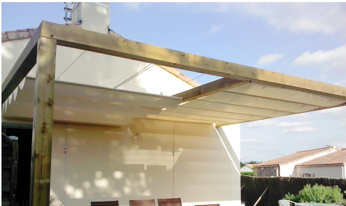
Système de toile tendue sur câbles, manoeuvrable en ouverture et fermeture par cordage.
