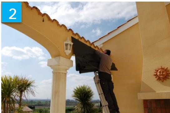
**1** Placer la toile côté fixe et la visser au mur avec les pitons à œil.
